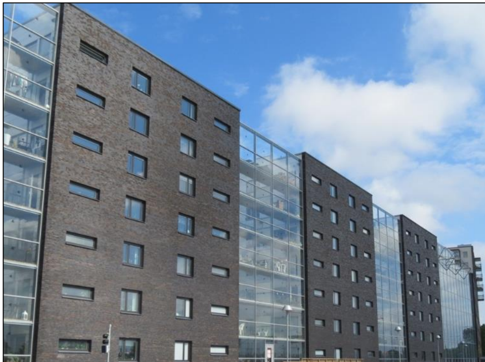
Figur C.5. Exempel på åtgärd i form av tät, avskärmande bebyggelse vid "Porlinsfabriken". (LEIAB, 2016)
